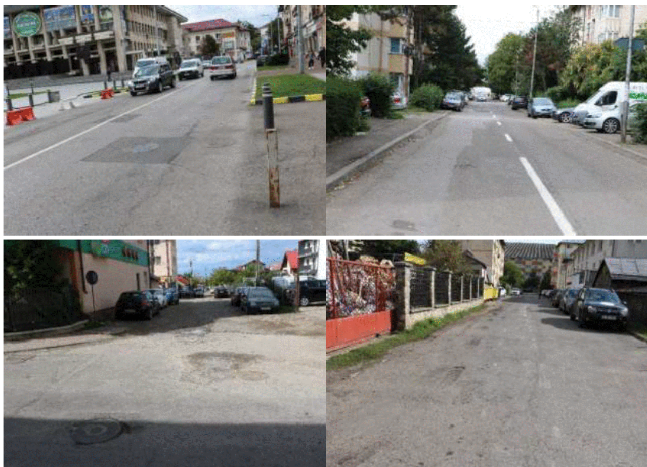
Figura 2.49. Străzi a căror suprafață de rulare se află în stare tehnică proastă/ neasfaltate.
