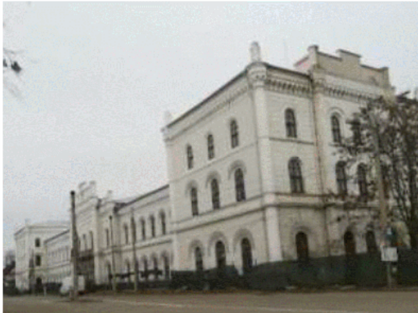
Figura 2.94. Stația Suceava Nord (Ițcani).
